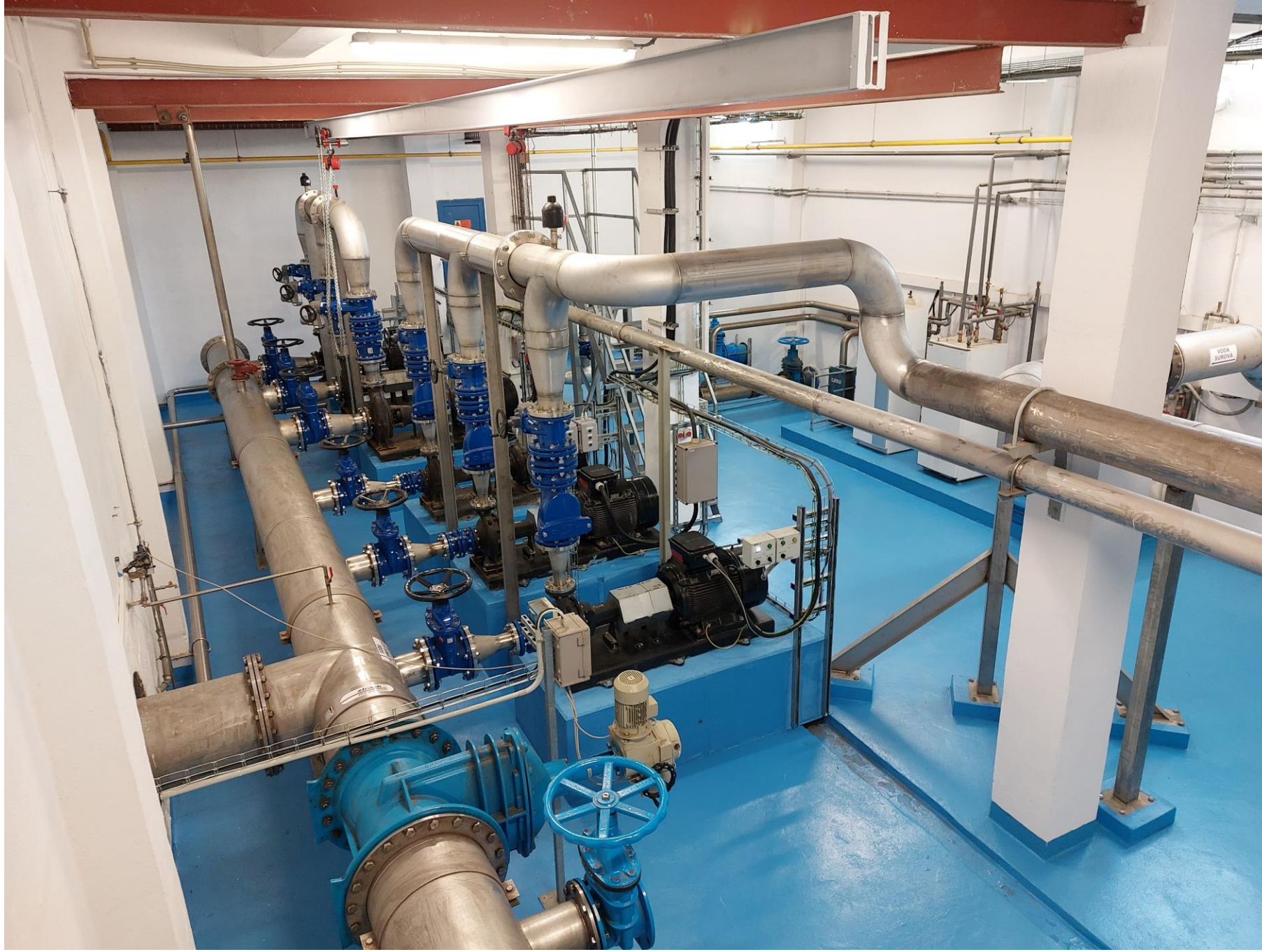
Doplnění čerpací stanice ÚV D.Bukovsko – výtlak směr VDJ Smrčí – Týn nad Vltavou - stav po dokončení technologie i nátěrů
