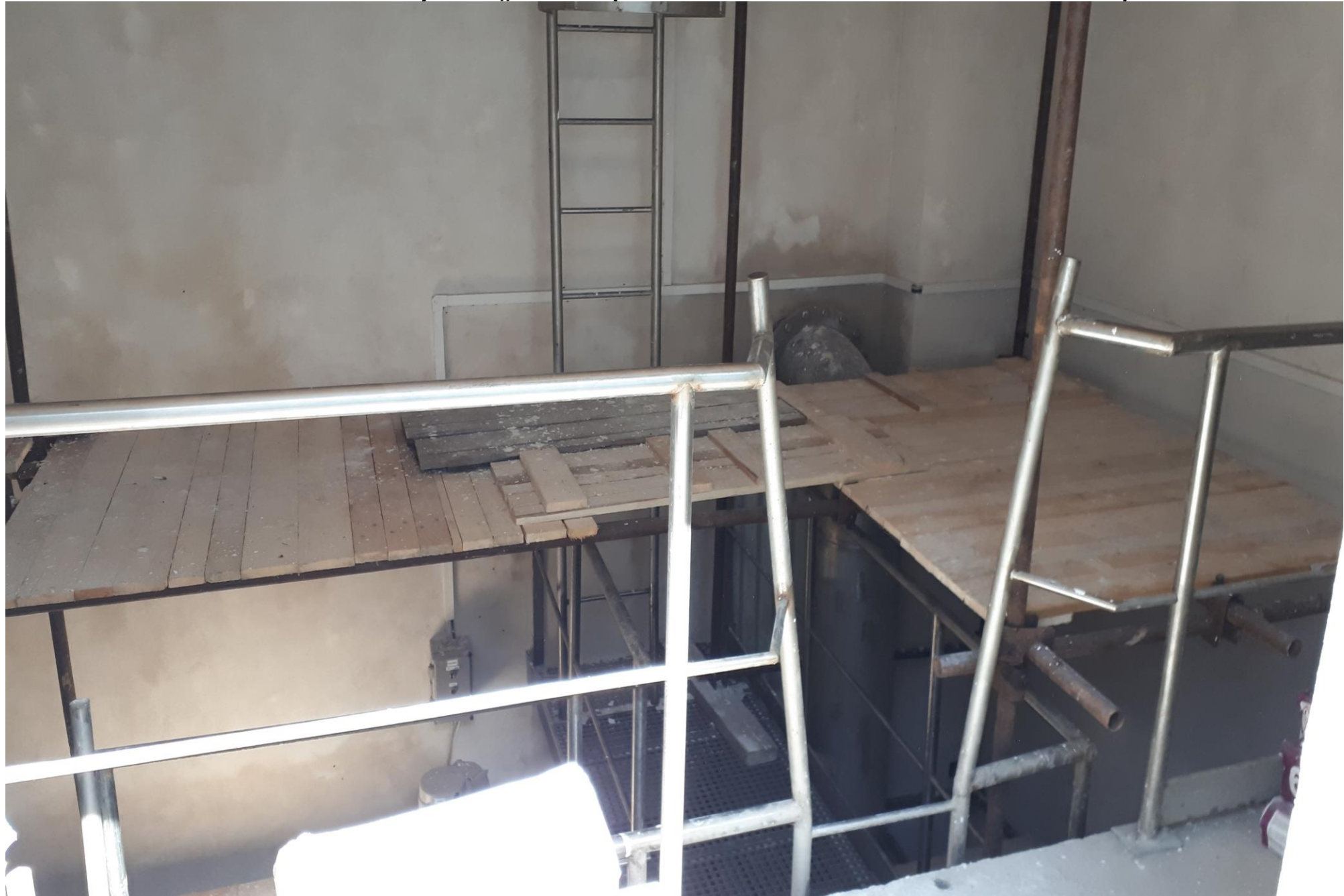
Obnova armaturní komory VDJ „A“ Starý 2000 m3 - ÚV Bukovsko – náklady 93 363 Kč
