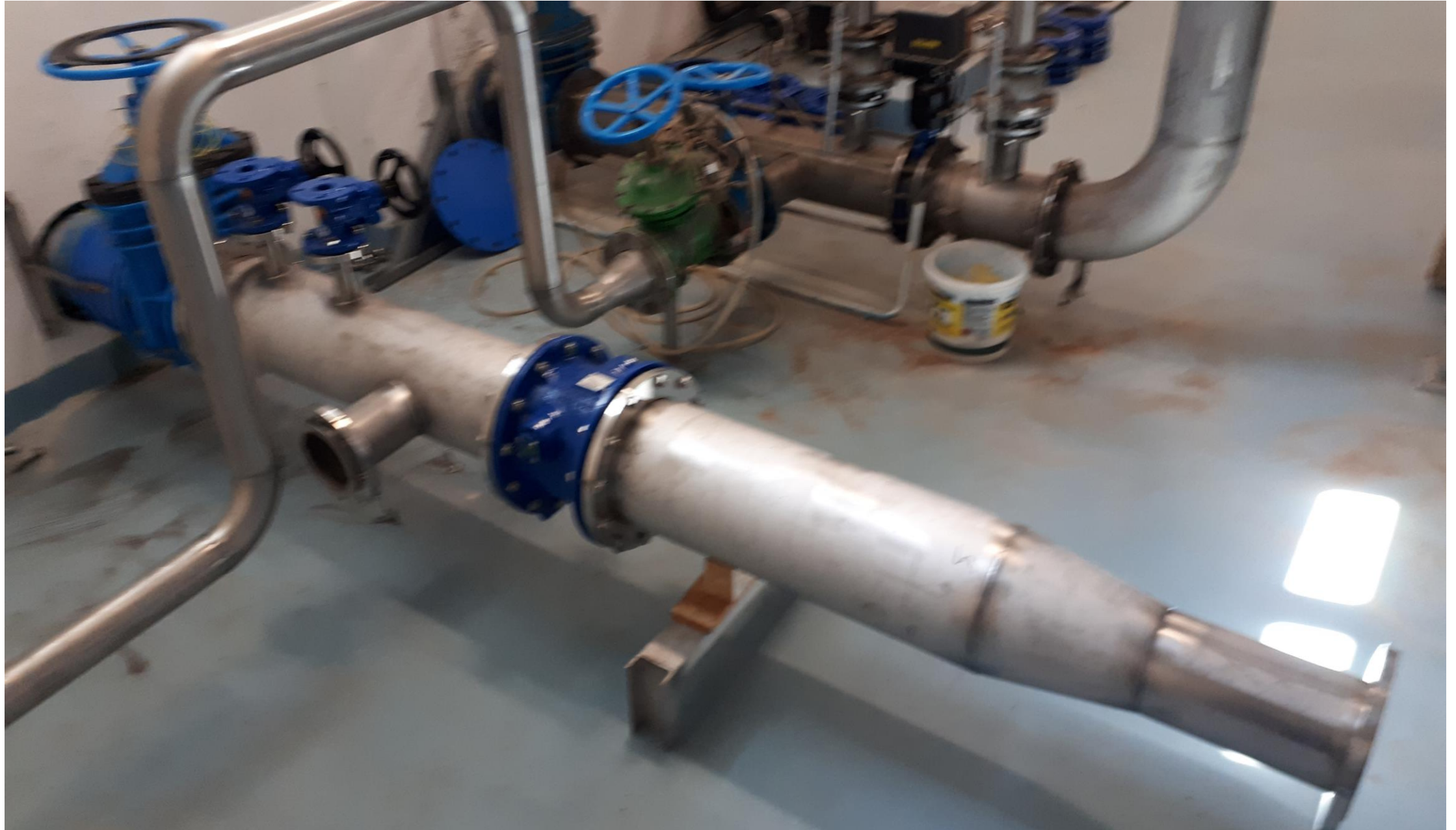
Doplnění čerpací stanice ÚV D.Bukovsko – provizorní přeložení přepadu eliminace tlakových rázů
