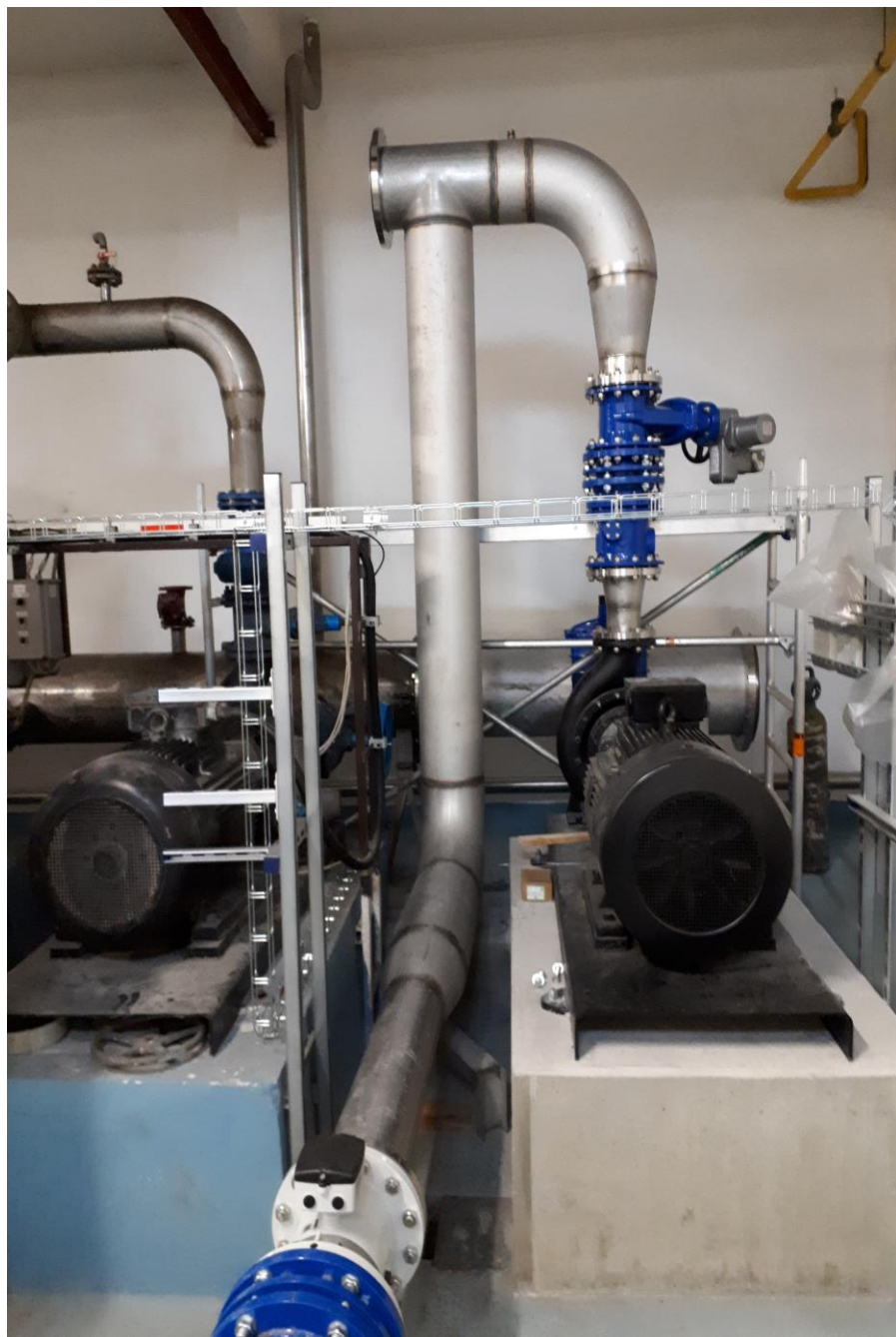
Doplnění čerpací stanice ÚV D.Bukovsko – montáž nového výtlaku směr J. Hradec
