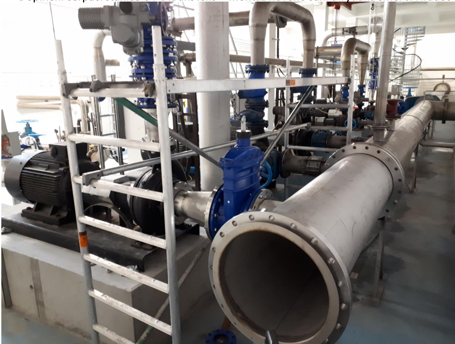
Doplnění čerpací stanice ÚV D.Bukovsko – montáž nového sání a výtlačku směr J. Hradec
