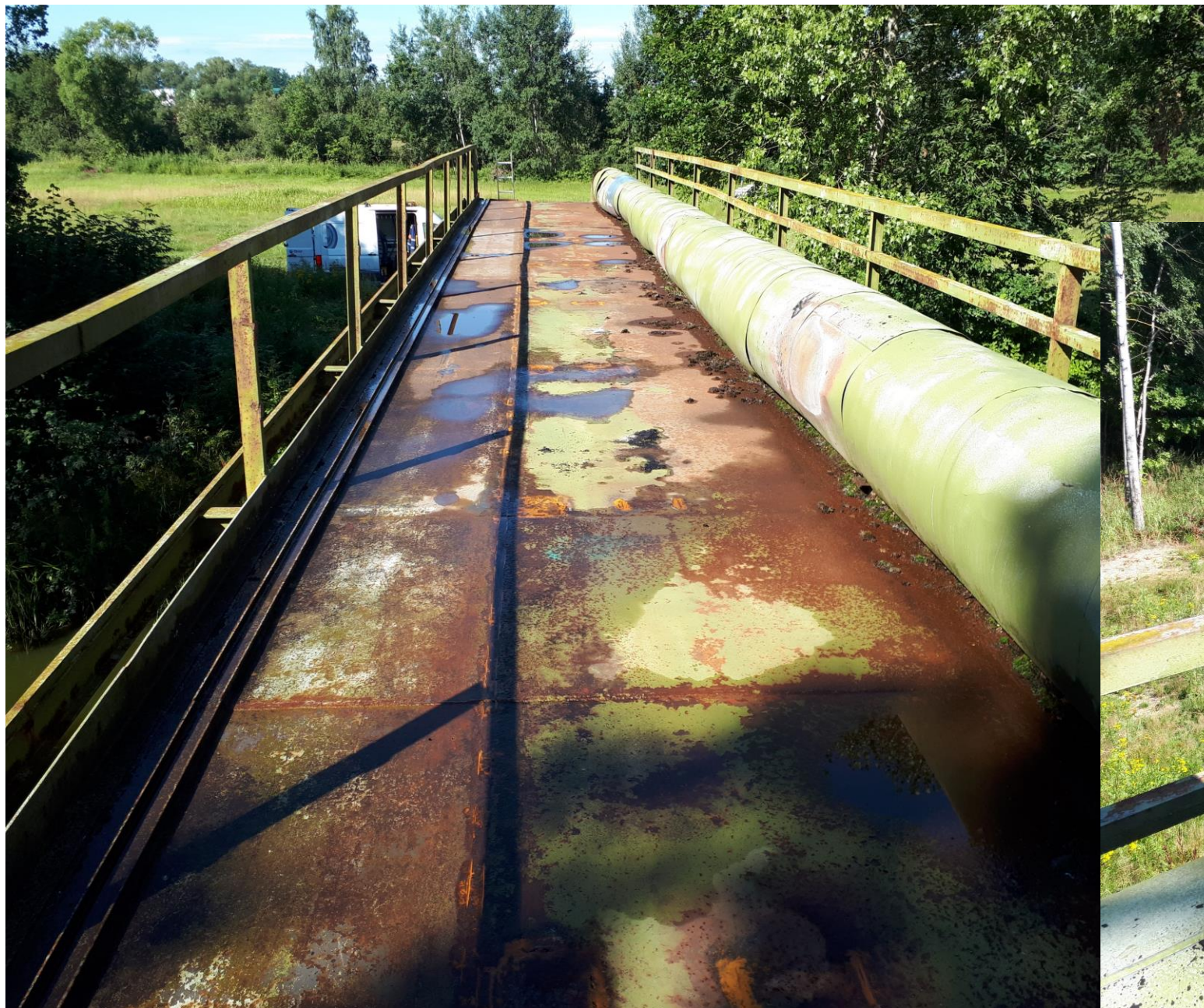
Mostní konstrukce Lužnice – opravy nátěrů, zabezpečení vstupu, oprava vzdušníku .
