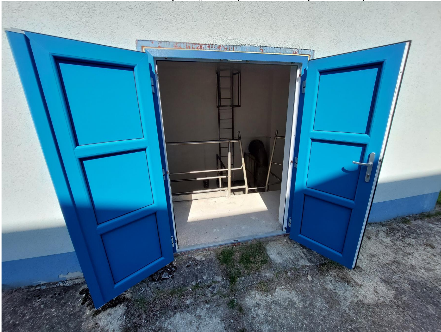
Obnova armaturní komory VDJ „A“ Starý 2000 m 3 – výměna vstupních dveří
