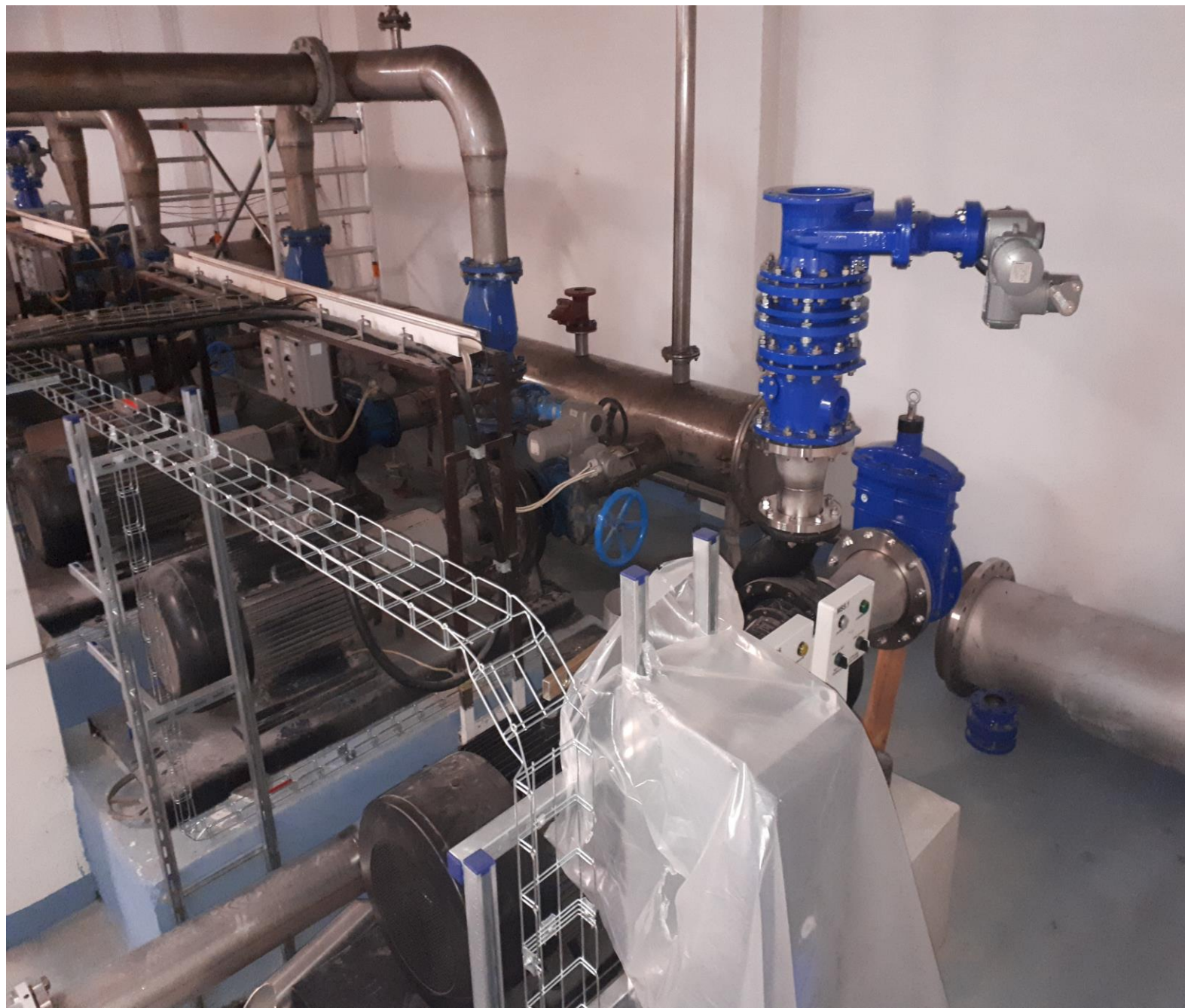
Doplnění čerpací stanice ÚV D.Bukovsko – montáž nového výtlaku směr J. Hradec
