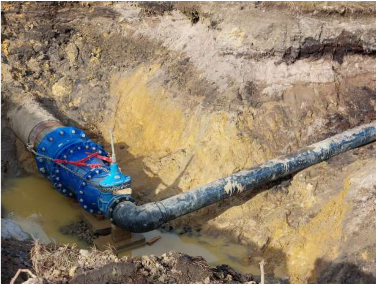
Obnova kalníkové šachty Drahov, provizorní přepojení DN 200
